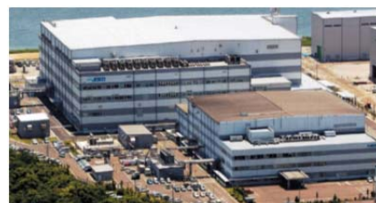
北九州 PCB 処理事業所 (福岡県北九州市若松区)
